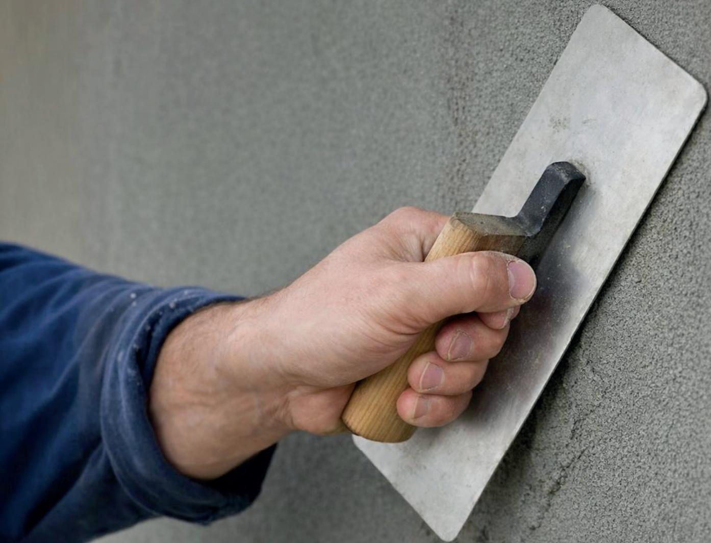
**Base Coat TECHA® Monocomponente** es un producto cementicio modificado con polímeros sintéticos, cargas minerales y aditivos especialmente seleccionados; desarrollado para ser preparado simplemente con el agregado de agua.
